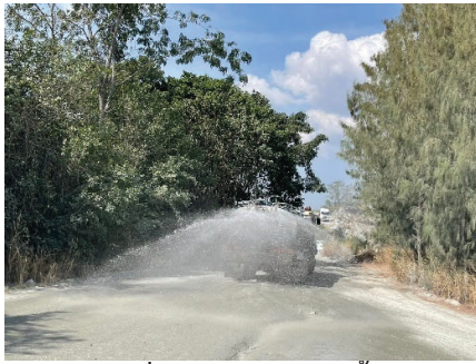
รูปที่ 2-9: การฉีดพรมน้ำ บริเวณเส้นทางลำเลียงแร่
